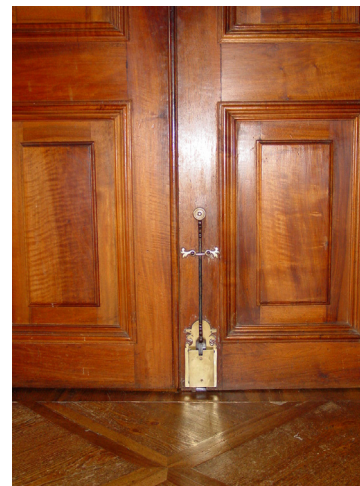
Proberestaurierung bei Türbeschlag
