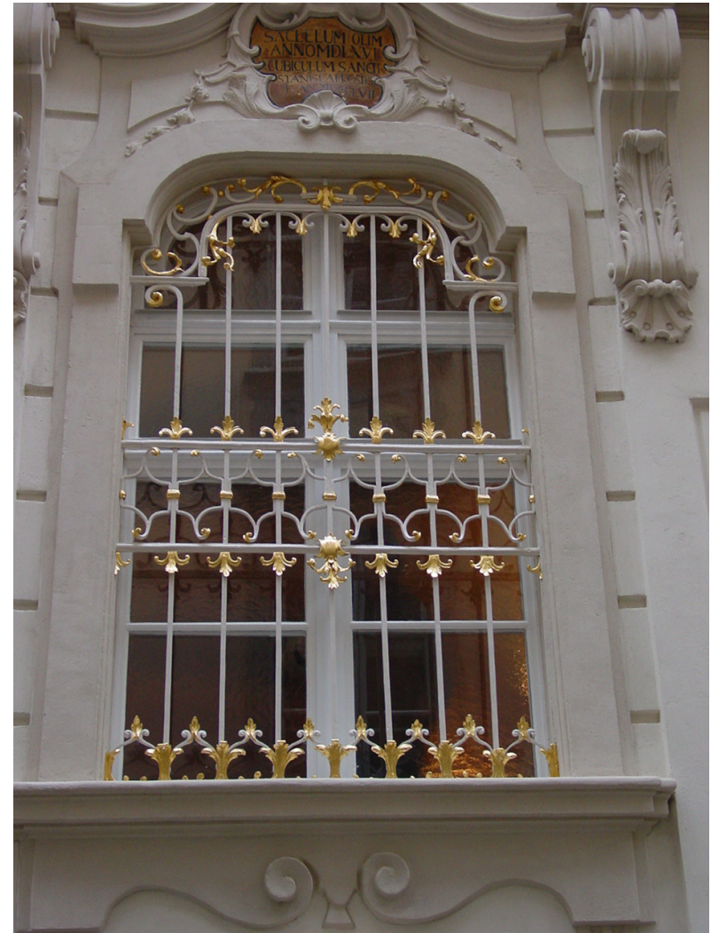
Hauskapellengitter - nach der Restaurierung
