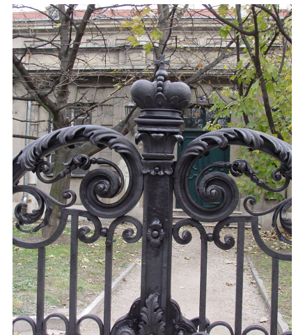
Mittelbereich eines Gitters - nach der Restaurierung
