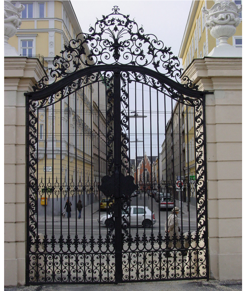
Oberes Belvedere - Toranlage seitlicher Haupteingang Historistisches Schmiedeeisentor Ausführungszeitraum: April - Oktober 2003
