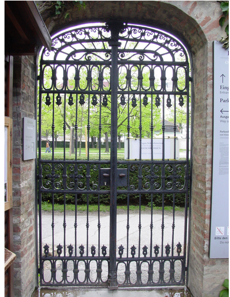
Oberes Belvedere - Tor zum Alpengarten - vor der Restaurierung Ausführungszeitraum: Mai - September 2005
