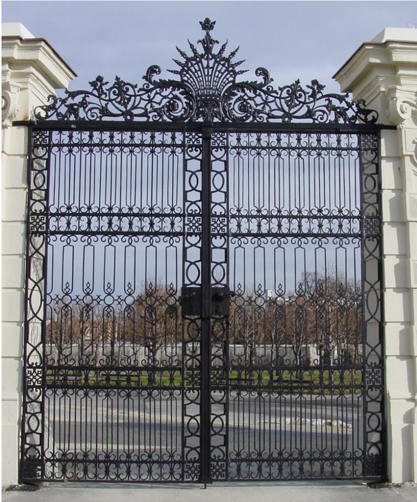
Oberes Belvedere - 2 Tore zum Teichhof an Ost- und Westseite Ausführungszeitraum: April - Oktober 2003 bzw. Mai - September 2005
