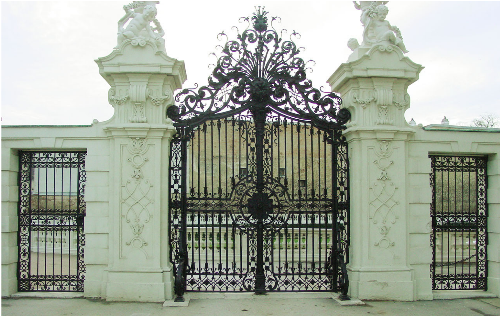
Unteres Belvedere, unteres Kammergartentor - nach der Restaurierung, Ausführungszeitraum April - September 2006
