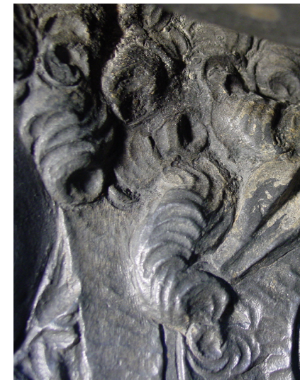
Korrosionsablagerungen an Oberfläche
