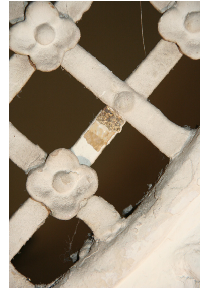
Freilegungstreppe an Rautengitter
