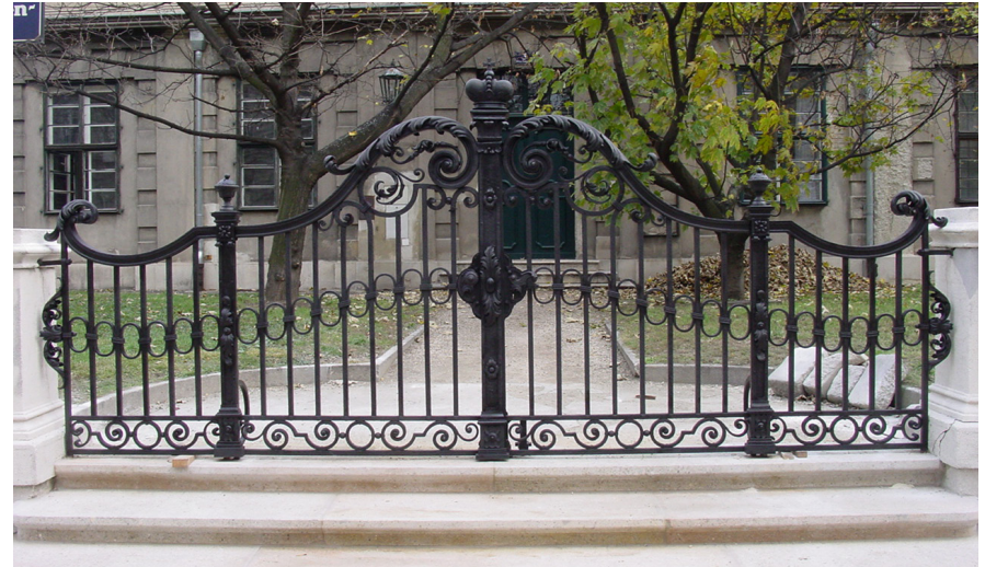
Parkgitter - nach der Restaurierung
