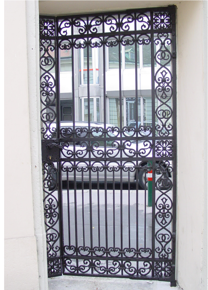
Unteres Belvedere - Toranlage Rennweg, rechtes Seitentor Schmiedeeisentor, um 1850 Ausführungszeitraum: April - Oktober 2004
