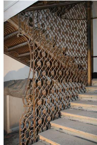
Stiepengitter und Metalltreppe
