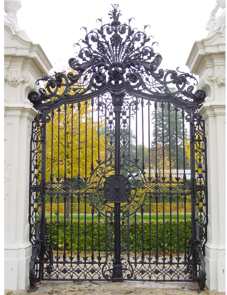
Oberes Belvedere - Oberes Kammergartentor Barockes Schmiedeeisentor Ausführungszeitraum: Mai - September 2004
