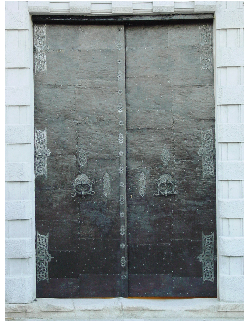
Tor zum oberen Burghof - nach der Restaurierung
