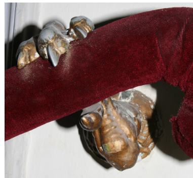
Freilegungsfeld bei Handlaufhalterungen aus Zinkguss
