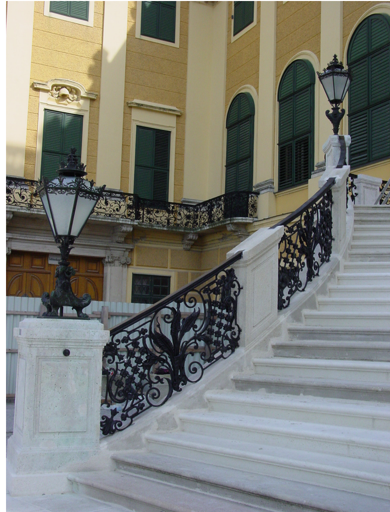
Treppengeländer und Laternen nach der Restaurierung
