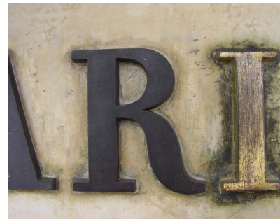
Abnahme der Fassungsreste und Schmutzablagerungen
