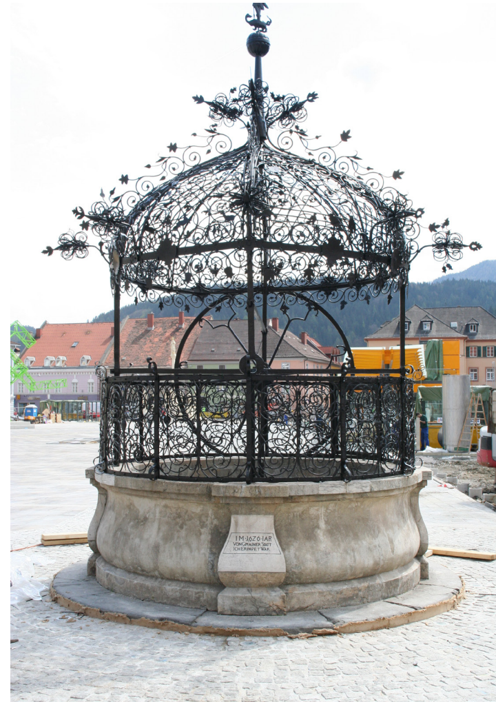
Eiserner Brunnen - nach der Restaurierung
